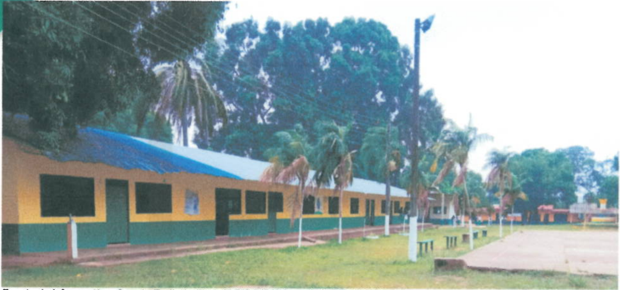
Imagen 4. Infraestructura IE Theodoro Weijnen.
