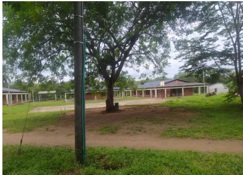
Instalaciones del centro educativo, Centro Poblado de El Porvenir Puerto Gaitán Meta
